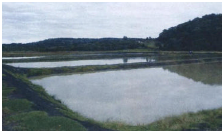
Figura 3: Estanques excavados en tierra
